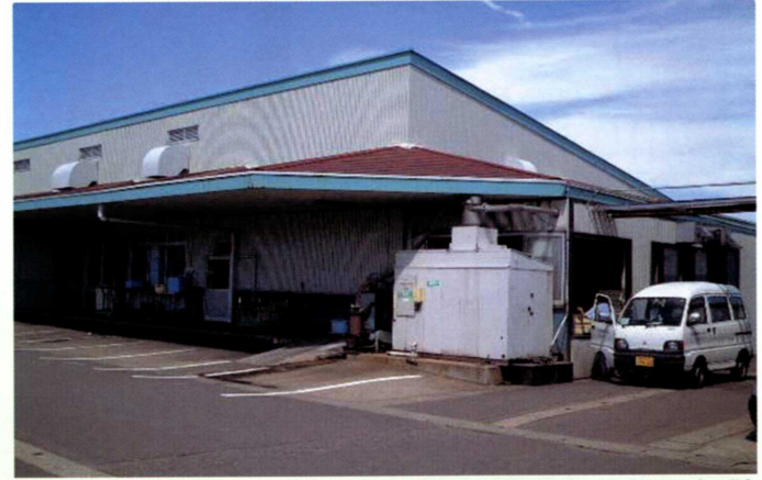
給食センター（バキューム投入方式）
